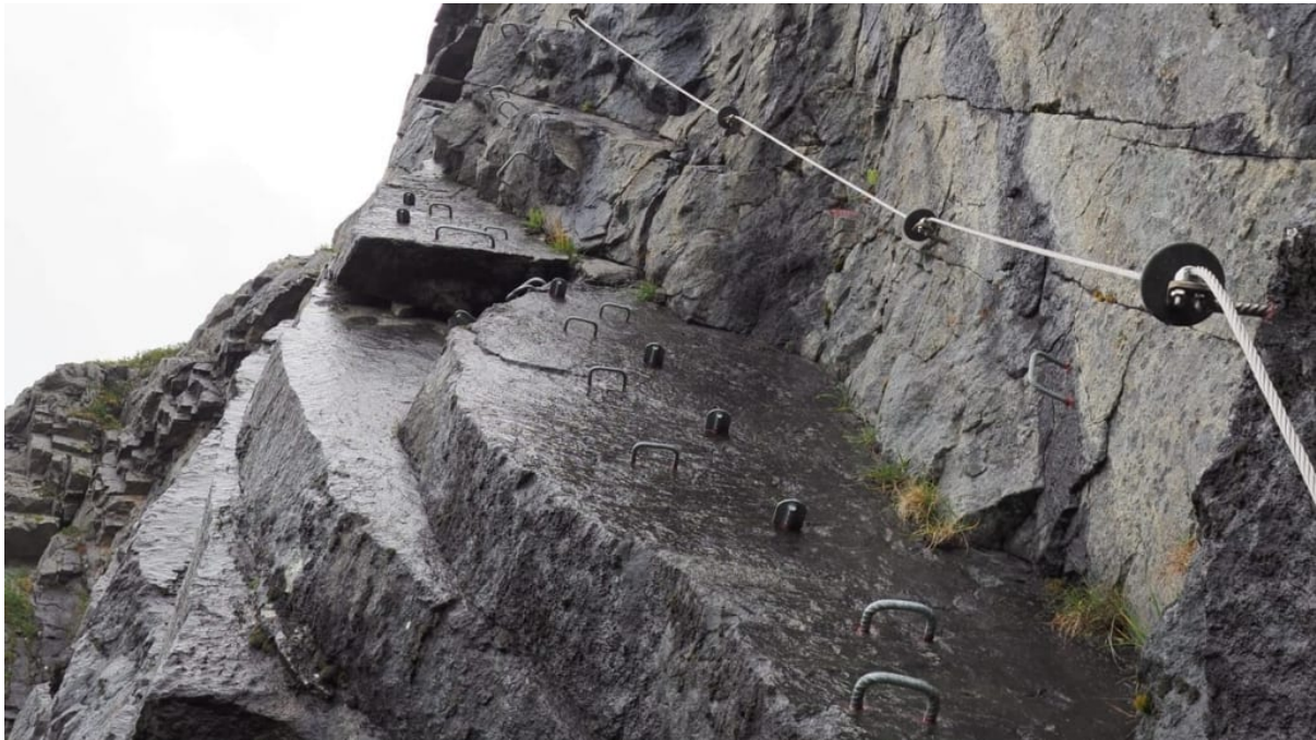
Figur 26: Eksempel på steg, bolter og vaier i fjellvegg. Bilde fra ravnfloget.no
