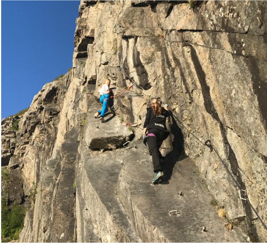
Figur 2-5 Illustrasjon av stegjern med sikringswire (foto: Norges Boltefond).
