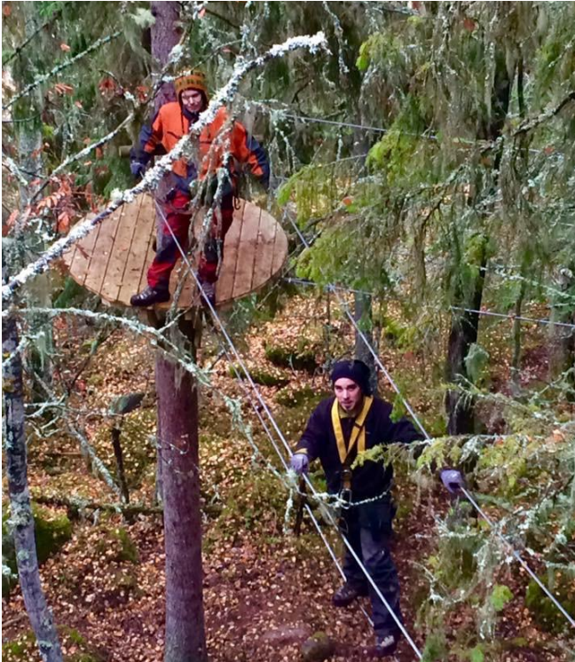
Figur 2-3 Illustrasjon av platting og såkalt "nepalbru" (ill. Norges Boltefond).
