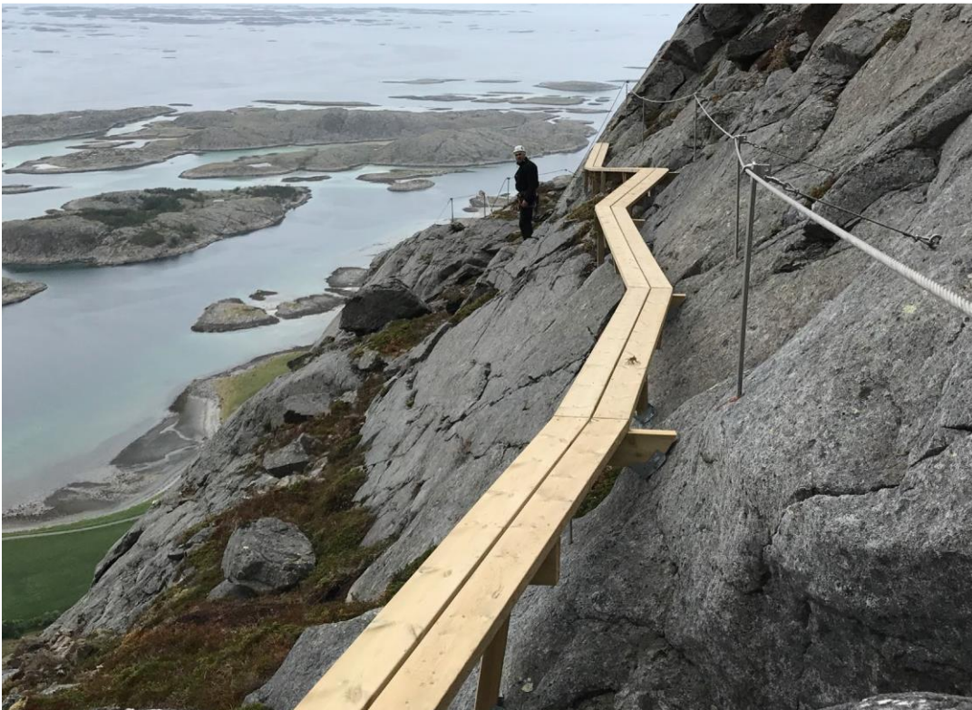
Figur 2-4 Illustrasjon av planket sti med sikringswire (foto: Norsk Boltefond).
