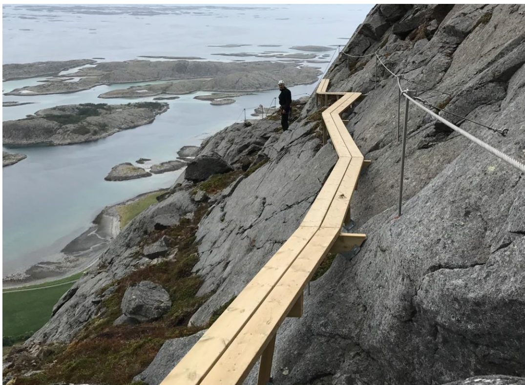
Figur 2-2 Illustrasjon av planket sti med sikringswire (foto: Norges Boltefond).
